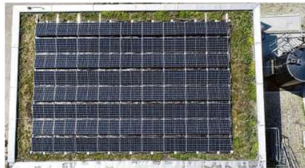
Die Solarmodule auf dem Dach der Kläranlage Vellberg liefern für den Eigenverbrauch Strom. *Foto: privat*
